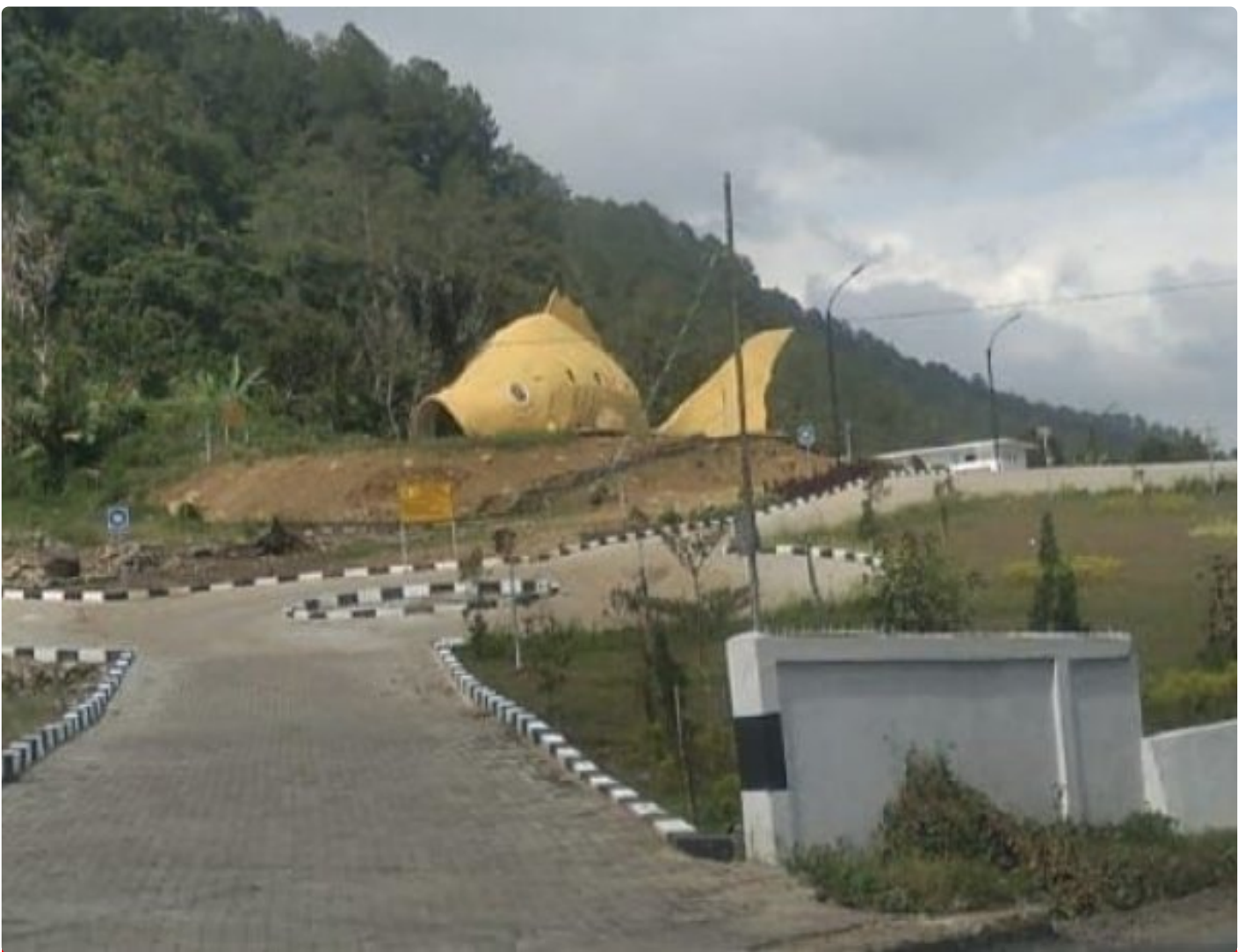
Proyek Pembangunan Ikan Mas Sipolha
